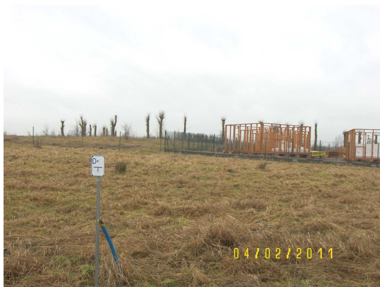
2. Widok nieruchomości w kierunku północno-zachodnim
